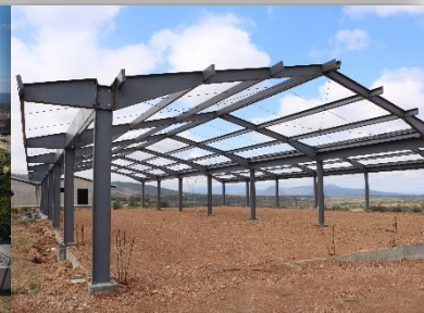
1ra. Etapa del laboratorio de IIAS y Arq.
